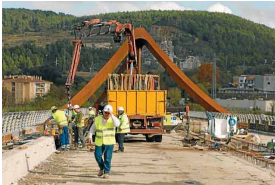
Els treballs al nou pont sobre el Ter a Girona, fa unes setmanes ■ GLÒRIA SÁNCHEZ / ICONNA
